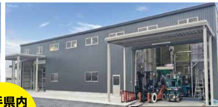
施工例 軒高6.0m 間口:24.3m 奥行:7.2m 機種: LW6-8040H 53.8坪
